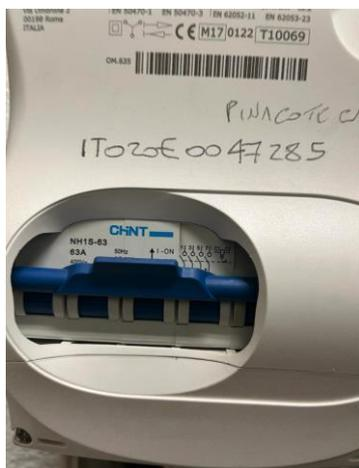
A valle del contatore è installato il quadro contenente l'interruttore generale con relè magnetotermici differenziali.
